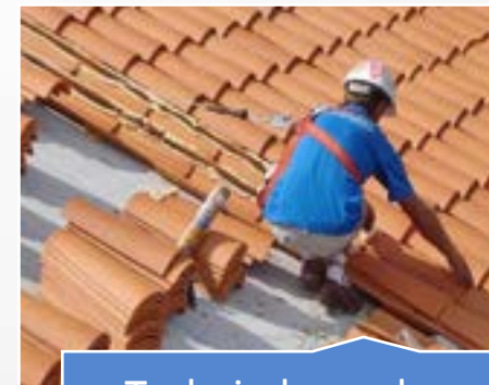
Trabajadores de cubiertas
