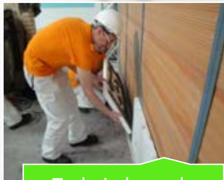
Trabajadores de aislamiento
