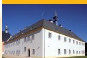
2. Rekonstrukce manéž Stanislava Křižana v Hostovicích
