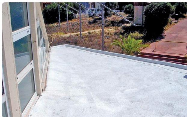
Figura 10. La copertura dopo l'applicazione del Cool Roof
