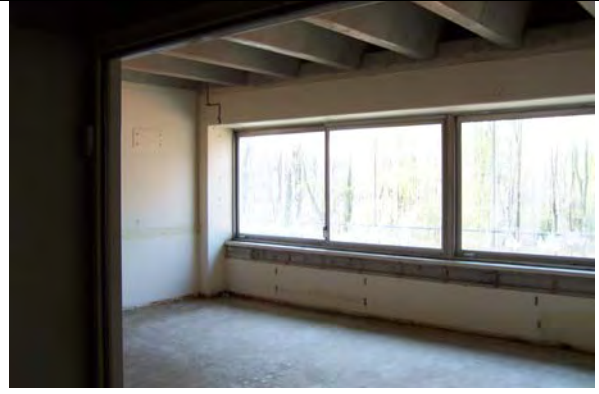
Bild 3–31: Aufbau neuer Wände zur Raumeinteilung
