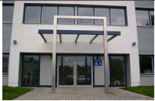
Bild 3–37: Eingangsbereich nach der Sanierung
