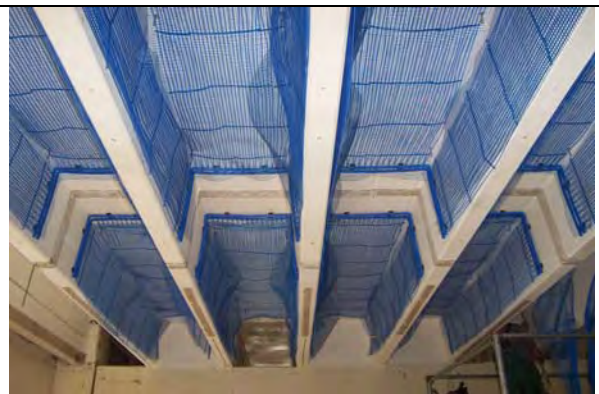
Bild 3–41: Kapillarrohrmatten zur Deckenkühlung vor dem Verputzen
