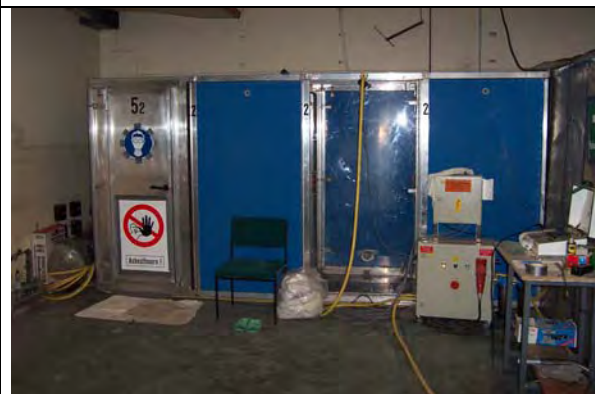
Bild 3-22: Schadstoffsanierung;Luftschleuse
