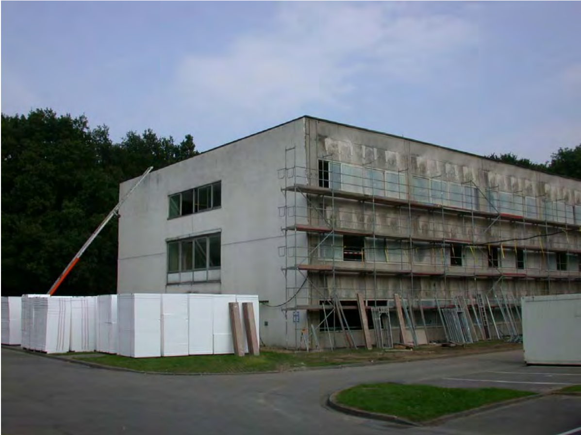
Bild 3–12: Gebäudehülle vor Beginn der Fassadendämmung
