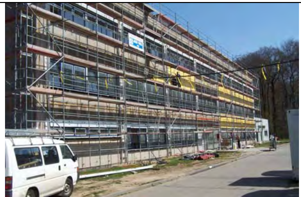
Bild 3–35: Aufbringen der Außendämmung
