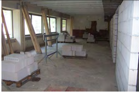
Bild 3–30: Aufbau neuer Wände zur Raumeinteilung
