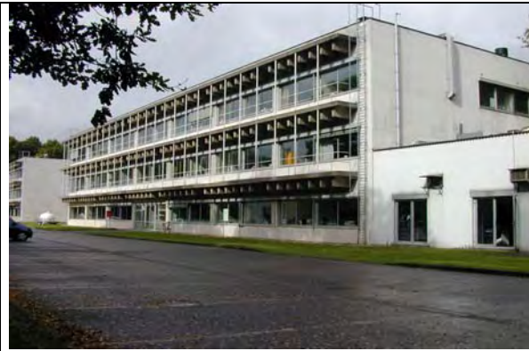
Bild 3-18: Gebäude 6.2 vor der Sanierung
