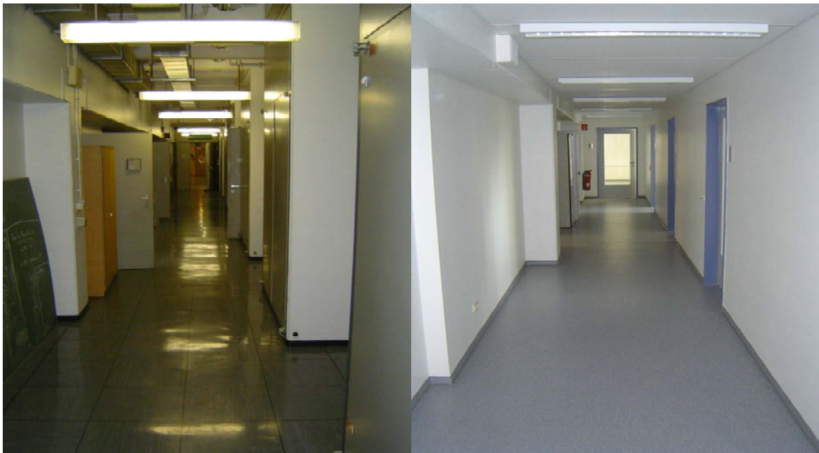
Bild 3–17: Flurbeleuchtung: vor der Sanierung (Kunstlicht) und nach der Sanierung (Tageslicht)
