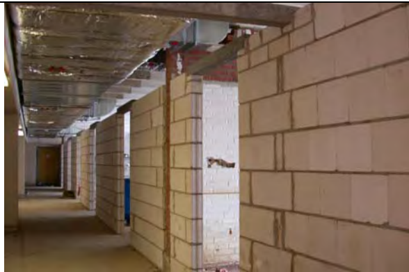
Bild 3–32: Aufbau neuer Wände zur Raumeinteilung
