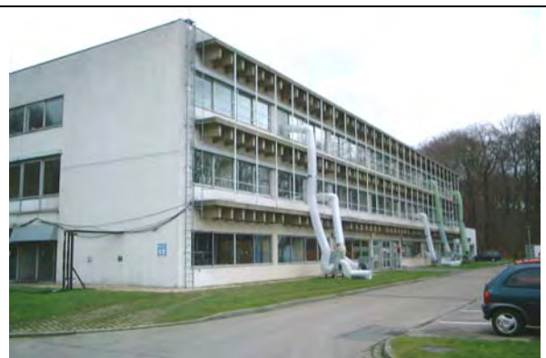
Bild 3-23: Schadstoffsanierung; Absaugung
