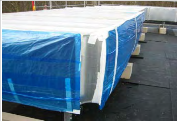
Bild 3-59 und Bild 3-60 : Abluftöffnungen der Lüftungskanäle auf dem Dach
