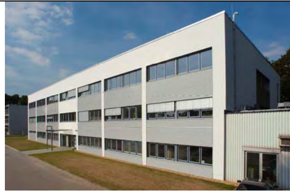
Bild 3–36: Gebäude 6.2 nach der Sanierung
