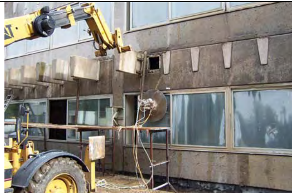
Bild 3-27: Abschneiden der Betonrippen
