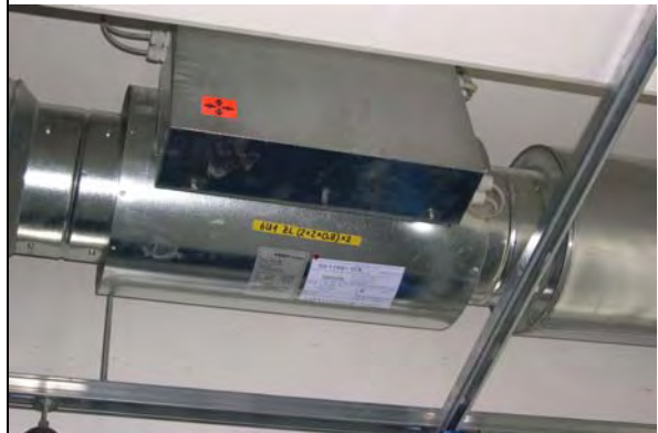
Bild 3–47: Luftvolumenstromregler zur Bedarfsabhängigen Regelung der Ab- und Zuluft
