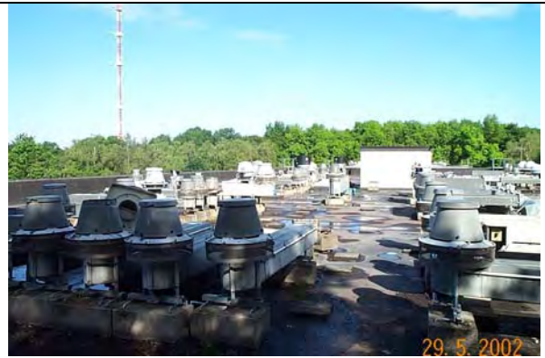
Bild 3-19: Dachaufsicht vor der Sanierung
