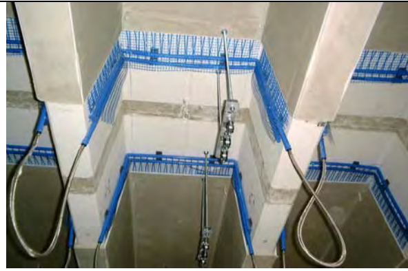
Bild 3–42: Kapillarrohrmatten zur Deckenkühlung nach dem Verputzen
