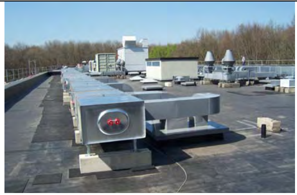
Bild 3–43: Dachaufsicht mit Sammelkanälen zur Wärmerückgewinnung
