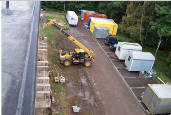
Bild 3-26: Abschneiden der Betonrippen
