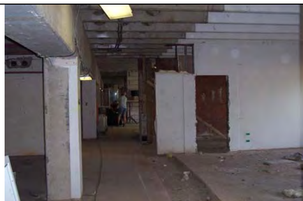
Bild 3-29: Entkernen des Gebäudes für eine neue Raumeinteilung
