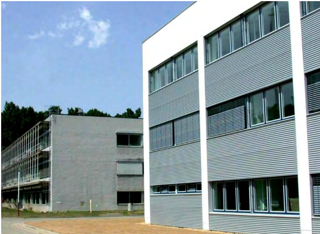
Bild 3–1: Gebäude 06.20 (Vordergrund) nach der Sanierung und das unsanierte Gebäude 06.10
