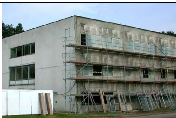
Bild 3-28: Außenfassade nach dem Entfernen der Betonrippen
