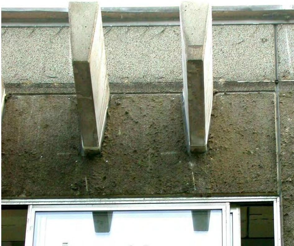
Bild 3–11: Kragarme unmittelbar vor dem Abschneiden
