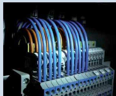
Abb. 95: Messserver Foto: Fraunhofer IBP
