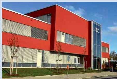
Abb. 19: Teilansicht der Gebäude-Südseite Foto: Winkler-Architekten
