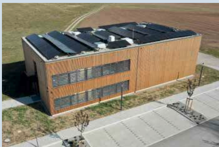
Abb. 58: PV-Anlage auf dem Dach der Halle Foto: Stadt Feuchtwangen
