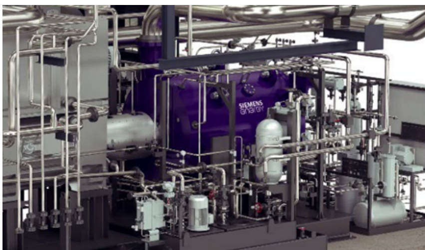
Figure 8 - Heat pump at Potsdamer Platz (Vattenfall).
