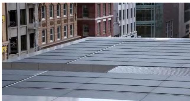
Figura 5 Pavimentazione fotovoltaica - Harrison street, New York a sinistra e Washington University a destra [Fonte: Onyx Solar<sup>13</sup>]
