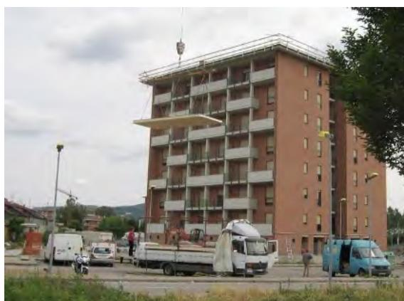
Figura 36 – Edificio ATC a Moncalieri – installazione di impianto solare termico (Fonte: Ambiente Italia)
