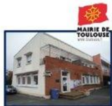
REHABILITATION GROUPE SCOLAIRE BENEZET
