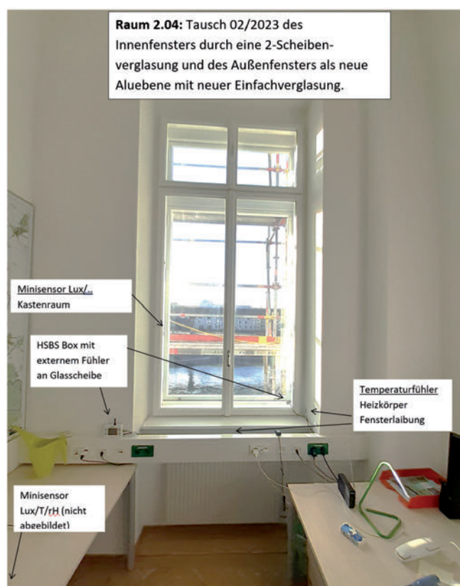
Abb. 5: Ausstattung Messsensorik an Musterfenster Raum 2.04, Foto ©: IBO
