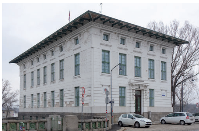
Abb. 1: Südwest-Fassade vor der Sanierung, Foto ©: Wiener-Komfort-Fenster
