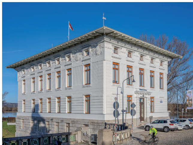
Abb. 2: Südwest-Fassade nach der Sanierung, Foto ©: Metz & Partner
