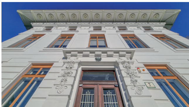
Abb. 3: Die Südfassade nach der Sanierung, Foto ©: Metz & Partner
