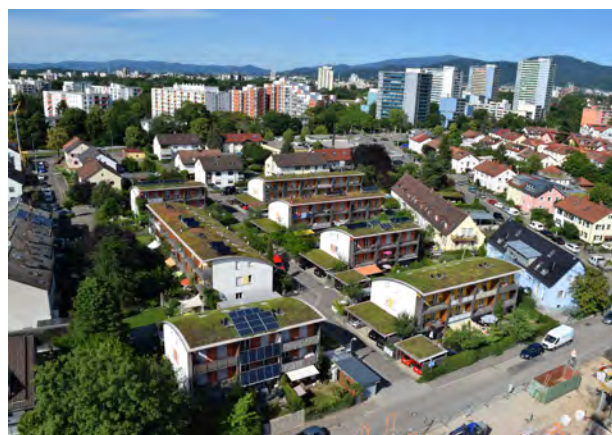
Abb. 56: Blick über ein Freiburger Wohngebiet – mit Jahrzehnte alten und immer noch funktionsfähigen Dachbegrünungen. Quelle: BuGG
