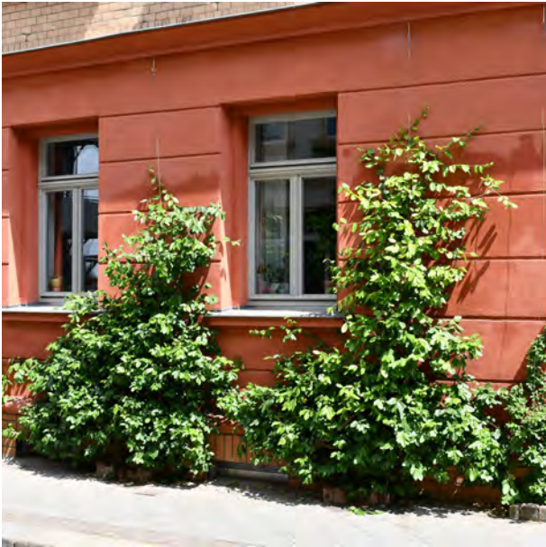
Abb. 58: Es ist nicht immer eindeutig, wieviele Quadratmeter begrünte Wandfläche einem laufenden Meter Kletterhilfe zugeordnet werden kann. Quelle: BuGG
