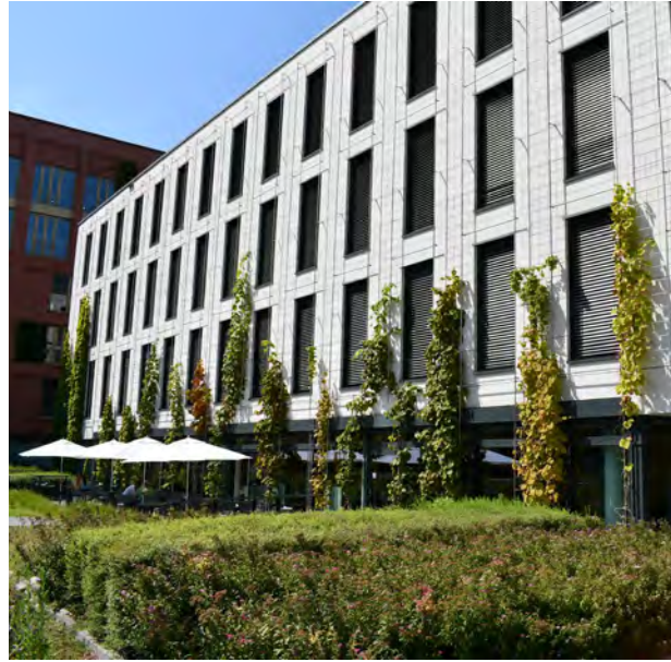
Abb. 59: Bodengebundene Fassadenbegrünungen mit Netzen bzw. Gittern lassen sich theoretisch gut erfassen ... Quelle: BuGG
