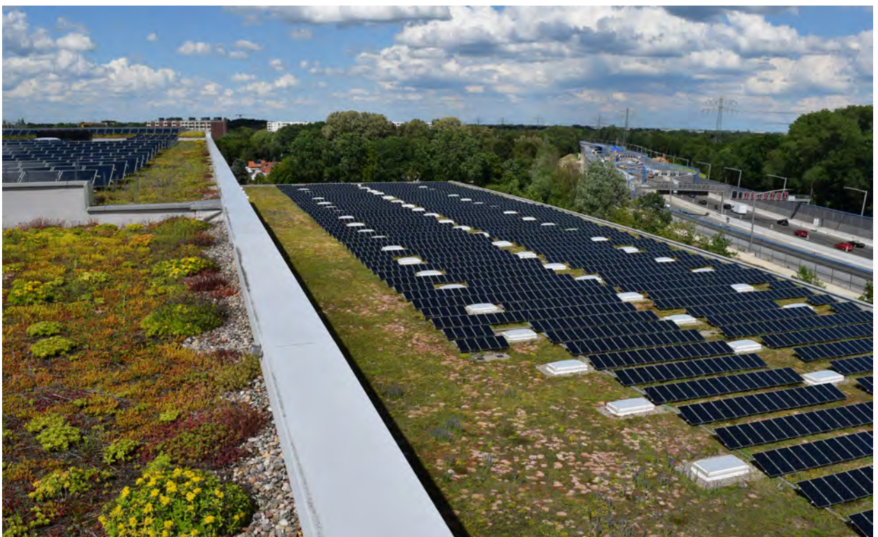
Abb. 10: Extensive Dachbegrünung, hier in Kombination mit Photovoltaik (Solargründach). Quelle: BuGG
