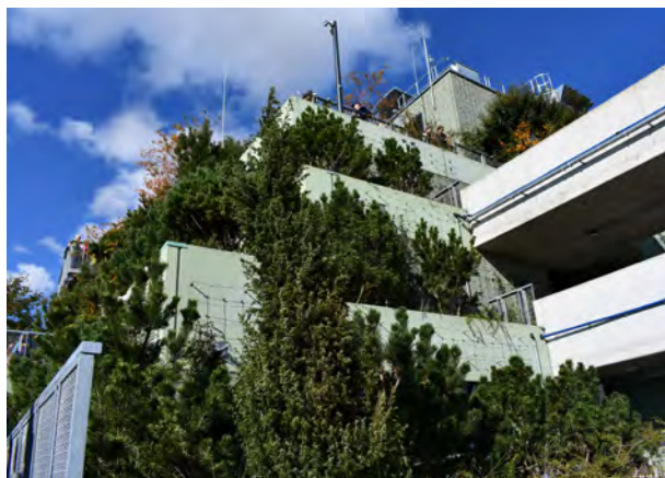
Abb. 21: Der Betonkoloss wurde mit rund 23.000 Pflanzen be- grünt. Quelle: BuGG
