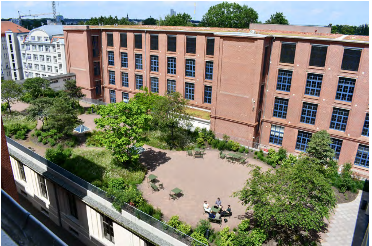
Abb. 49: Im Vergleich zum Vorjahr war ein Anstieg der Intensivbegrünungen zu verzeichnen. Quelle: BuGG
