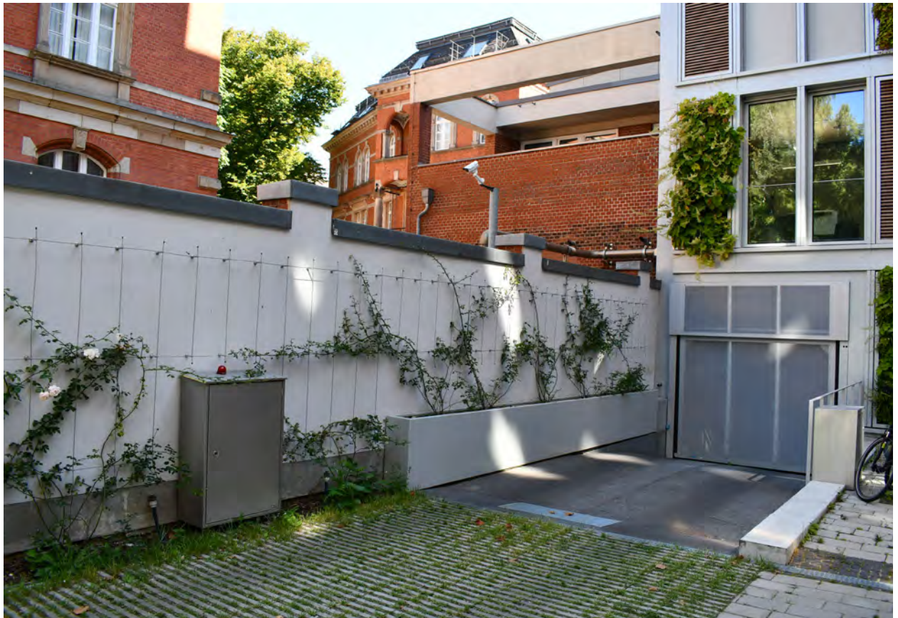
Abb. 57: In Deutschland wurden in 2023 etwa 102.700 m 2 bodengebundene Fassadenbegrünungen mit Kletterhilfen (links im Bild) und etwa 27.700 m 2 wandgebundene Fassadenbegrünungen (rechts im Bild) umgesetzt. Quelle: BuGG
